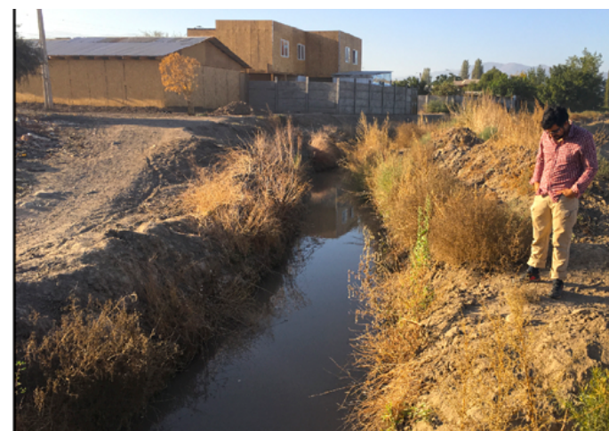
Figura 4. Canales no revestidos cercanos a un centro urbano.
